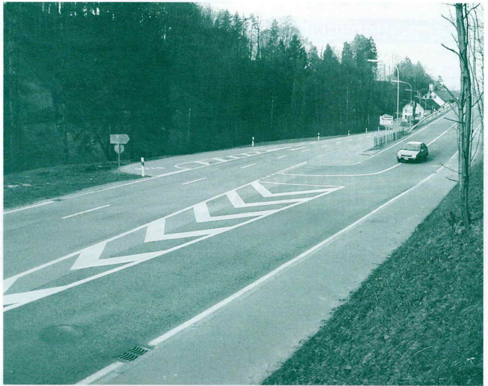
Der Abzweiger nach Rüti ist ein grosses Problem. Die Fahrzeuge sind gezwungen, weit auf der Gegenfahrbahn auszuholen, um die Kurve zu kriegen. Fotos: Werner Brunner
