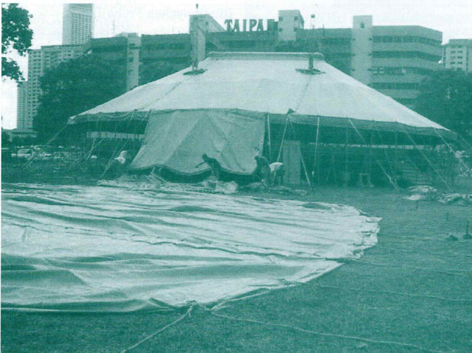
Mühsamer Zeltaufbau inmitten der südostasiatischen Millionen-Metropole Singapur mit nur acht Leuten bei 34 °C im Schatten.
