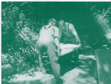
Am Plättliweg mussten schwere Betonplatten ersetzt werden. (Fotos: Heinz Bachmann)
