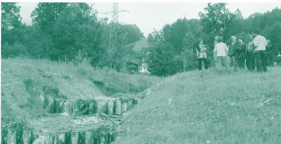
Das neue Bachbett des renaturierten Hirschwilerbachs.
