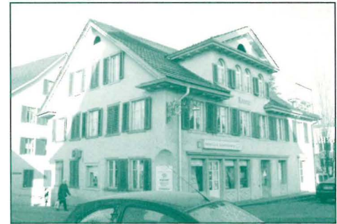
Das 1838 erbaute Haus beherbergte bis Anfang des 20. Jahrhunderts den «Gasthof zur Krone». Später waren darin der Laden und die Molkerei der Milchgenossenschaft Krone untergebracht, der das Haus noch heute gehört.
