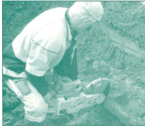
Das defekte Leitungsstück wird herausgetrennt.
