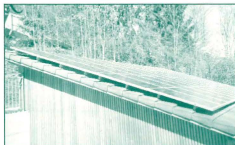
Sonnenkraftwerk: Private 10-Kilowatt-Anlage Binzholzstrasse. (Fotos: Marcel Sandmeyer)
