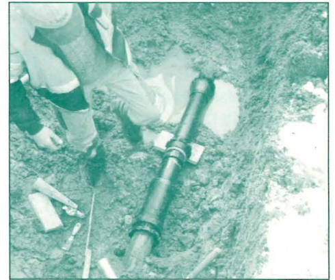
Schon ist die Leitung fast fertig repariert.
