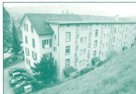
Das Kosthaus von der Treppe zum Burg-Schulhaus her gesehen. Gut erkennbar die vor etwa 30 Jahren errichteten Anbauten, die es erlaubten, Badezimmer einzubauen.
