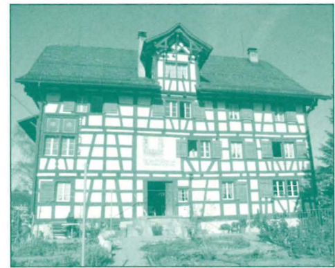
Markstein in der Baugeschichte des Zürcher Oberlands. Das durchgehende Sichertriegelwerk war damals einzigartig.
