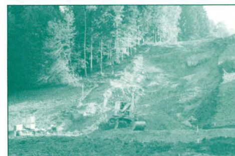
Von der ersten Erdbewegung (unten) bis zum fertigen Turm (oben): 2,3 Millionen Franken investiert. (Foto: ü)
