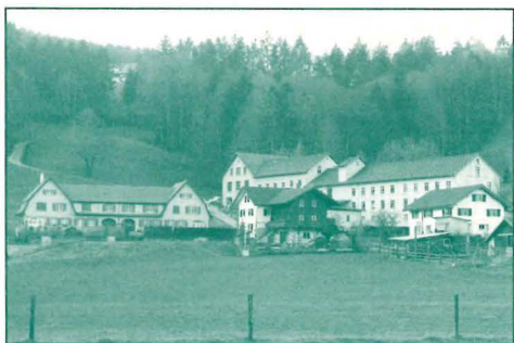
Das Zentrum Hueb: Rechts hinten die Fabrikgebäude, welche bald die Besitzer wechseln werden. Links das herrschaftliche Haus, in dem früher die Webermeister-Familien wohnten.
