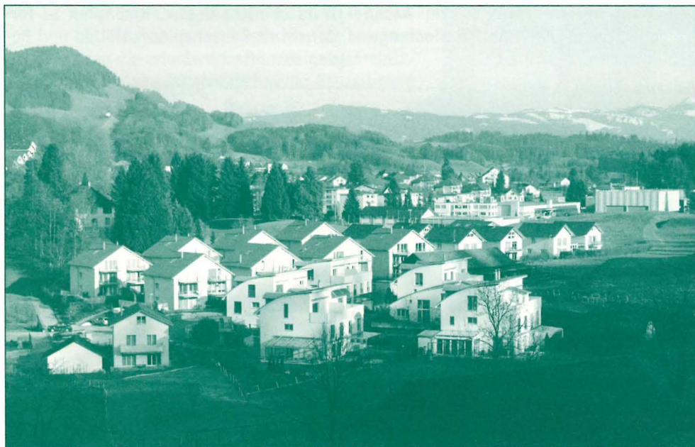
Nachher: Die Obstbäume und Scheunen sind weg. In verschiedenen Bauetappen entstanden über 30 neue Wohnhäuser. (Foto: Ursula Geiger)
