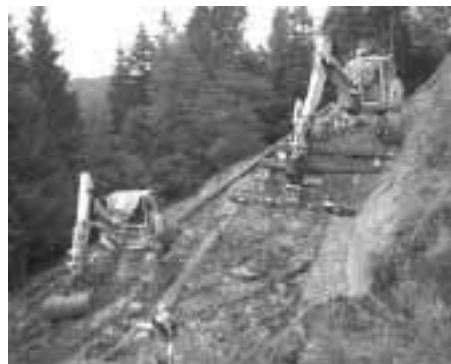
Spezialität von Zumbach: Hangverbauung
