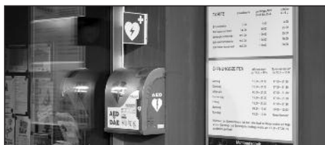
... beim Hallenbad Windegg und ...
