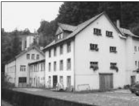
Weberei Thal (Grundtal) 1856 später: Spulenfabrik, Wolldeckenproduktion 1994: durch Brand beschädigt heute: Wohnen, Gewerbe
