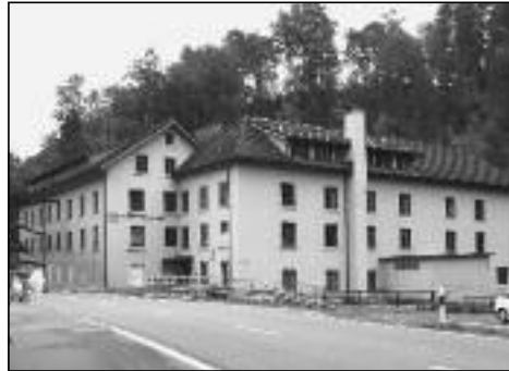
Weberei unteres Grundthal 1859–1984 heute: Gewerbe, Büros
