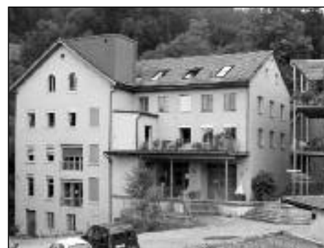
Weberei Diezikon 1851–1932 später: Schokoladenfabrik heute: Wohnen
