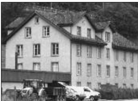
Weberei oberes Grundthal 1857–1972 später: Tricot Vogt heute: Lagerräume
