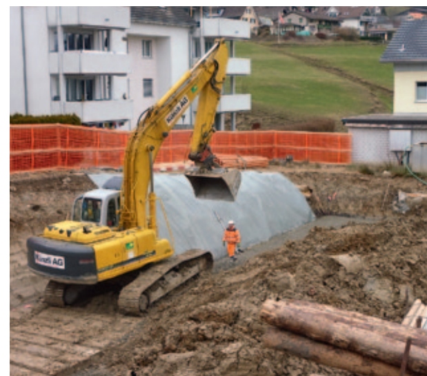
Aktuelle Baustelle: An der Mürtschenstrasse (Laupen) entstehen zurzeit fünf neue Wohneinheiten.
