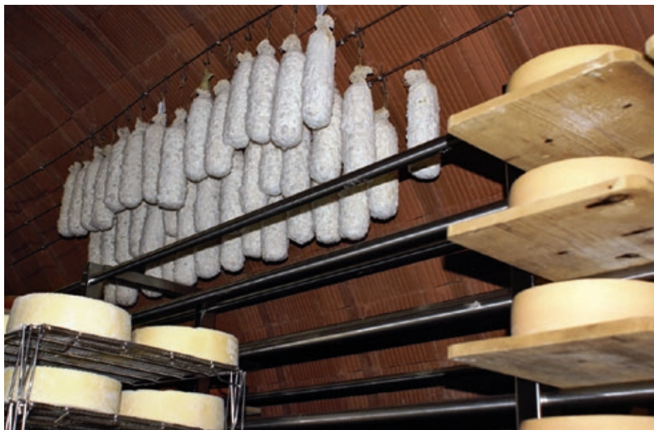
Das Tondecken-Gewölbe in den Käsekellern sorgt für ein optimales Mikroklima.
