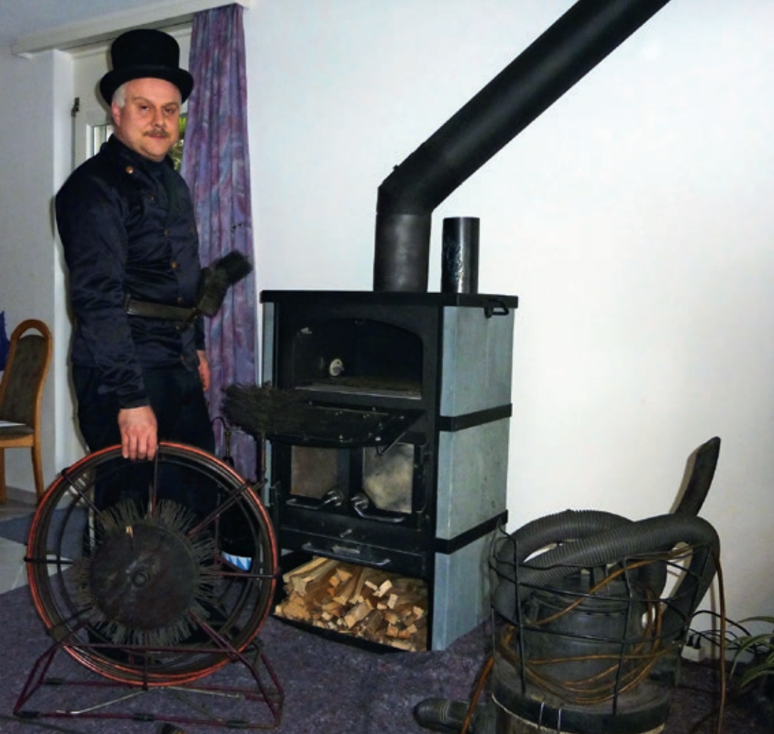
Kaminfegermeister Hans Kupper verhilft einem Schwedenofen zu einem russfreien Abzug. Diese Öfen sind besonders beliebt, um in der Übergangszeit Schlechtwetterphasen zu überbrücken.
