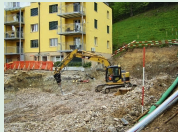
«Den Lärm beim Ausheben dieser Baugrube muss man sich dazu denken.» Hans Warthmann fotografierte am Schiblriraweg.
