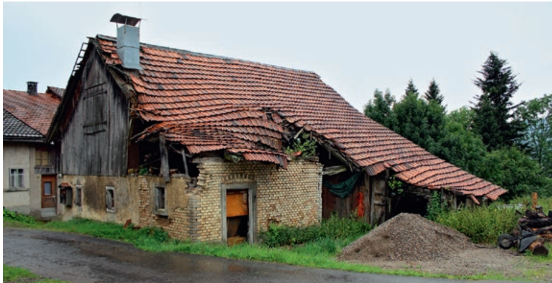
Ein krasses Beispiel von Zerfall: Die Scheune im Steichramen (zwischen Raad und Hischwil) kann nur noch – auf eigene Kosten – abgerissen werden.
