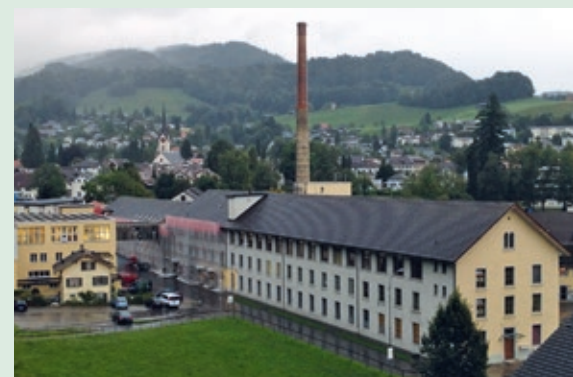
Bleiche-Kamin trotz Wind und Wetter, fotografiert von Ueli Blöchliger.
