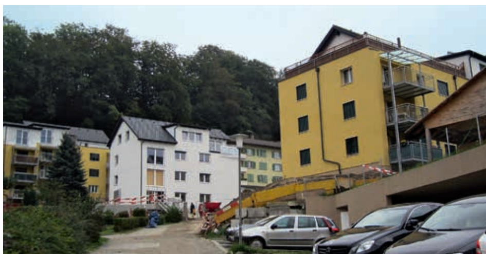
Verdichtetes Bauen am Schiblliraiweg: gelb die bestehende Bausubstanz, weiss die aufgesetzten Attika-Wohnungen und der Neubau. (Foto: Susanna Lerch)
