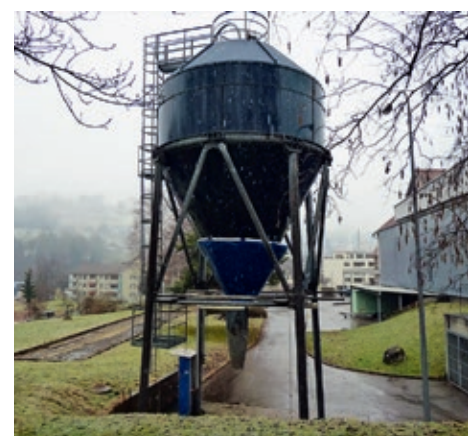
80 Tonnen Fassungsvermögen hat das Salzsilo im Keller-Areal. (Foto: Marina Koller)
