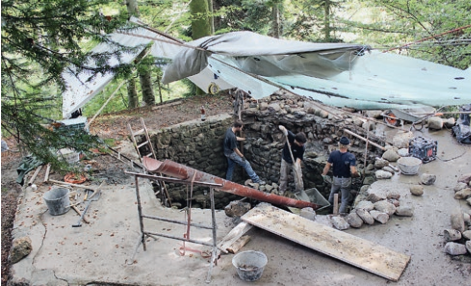
Bei der Sanierung in diesem Herbst versuchte man, mit den vorhandenen Steinen das Mauerwerk zu flicken. (Foto: Werner Brunner)
