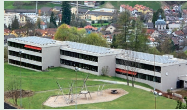
Die Photovoltaikanlagen auf dem Schulhaus Neuwies sind installiert. (Foto: zVg)
