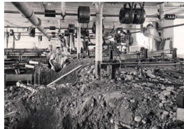
Der Maschinensaal der Fabrik Hübli.
