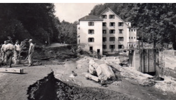
Zerstörung beim Kraftwerk Wellenwoog.
