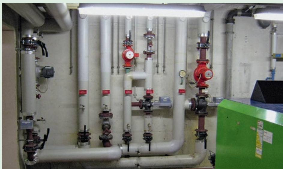
Die Haus- und Badwassertechnik im Hallenbad ist sanierungsbedürftig. Über die entsprechende Projektierung kann an der Gemeindeversammlung vom 2. Dezember abgestimmt werden. (Foto: zVg Gemeinde Wald)
