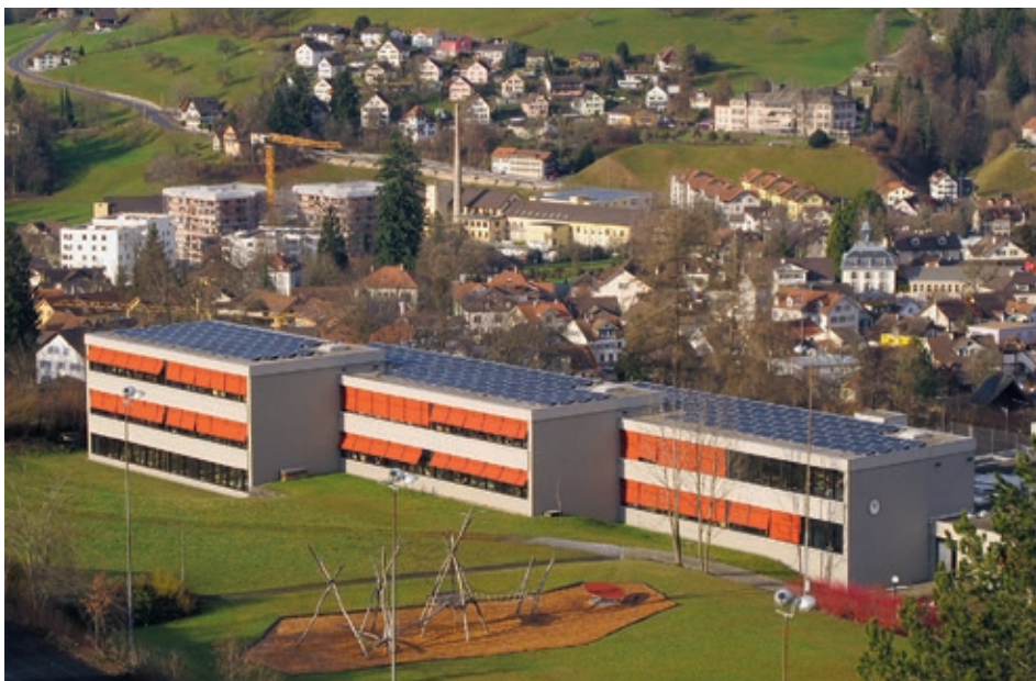
Die Fotovoltaikanlage auf dem Schulhaus Neuwies mit einem Jahresertrag von 60 000 Kilowattstunden. Jedermann kann sich daran beteiligen. (Foto: Marcel Sandmeyer)
