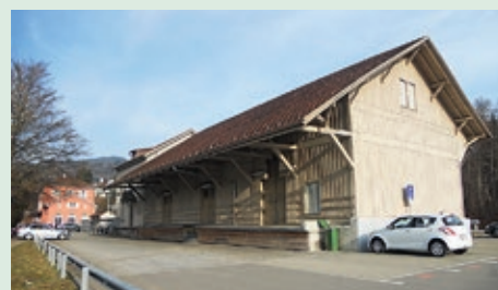
Der Güterschuppen beim Bahnhof darf abgerissen werden. (Fotos: Martin Süss)
