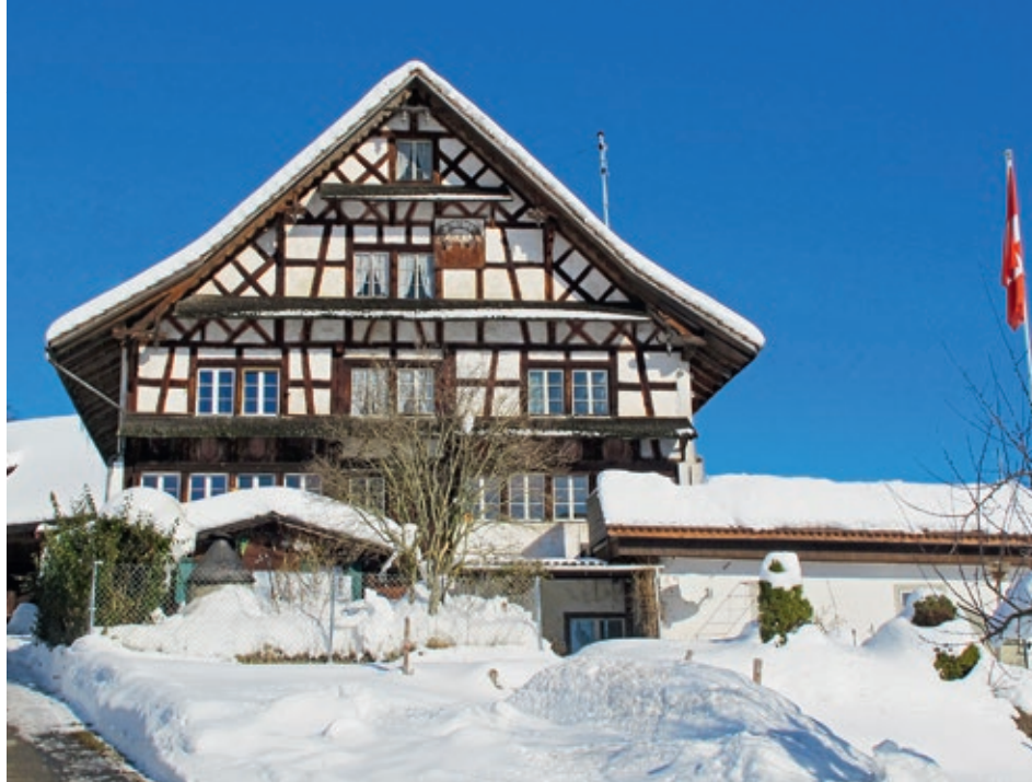
Der Fachwerkbau mit Klebdächlein und Uhr an der Fassade zeugt von seinen einst begüterten Erbauern. (Foto: Marcel Sandmeyer)
