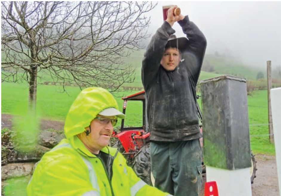
Routiniers am Werk: Andreas Kindlimann (rechts) und Othmar Hüppi setzen die Lockpfosten. (Fotos: Kaspar Rüegg)
