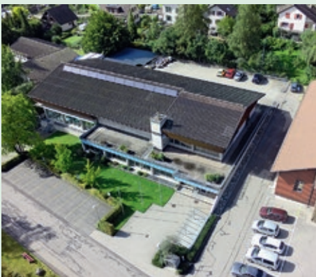
Die Haus- und Badewassertechnik des Hallenbades ist sanierungsbedürftig – ein entsprechender Antrag in Varianten bezüglich Wärmeversorgung wird den Stimmberechtigten Ende November vorgelegt.
