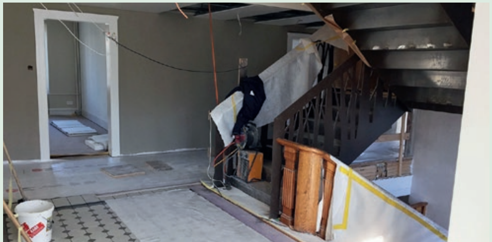
Neuer Treppenzugang ins Dachgeschoss des Gemeindehauses, Baustand Mitte Februar 2016. (Fotos: zVg)
