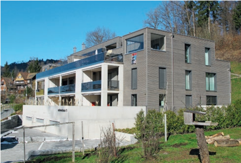
Eschenstrasse 11: Das erste in Minergie-P-ECO erstellte Mehrfamilienhaus. Viel Holz als Baustoff sowie Photovoltaikmodule an Terrassenbrüstungen und auf dem Dach. (Foto: Marcel Sandmeyer)
