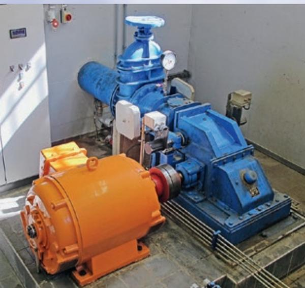
Jonapower vom Neuthal. Das erste Kleinwasserkraftwerk entstand hier 1881. Die Turbine (blau) mit Baujahr 1991 treibt den Generator (orange). (Foto: Marcel Sandmeyer)
