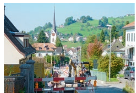
Engpass an der Sanatoriumstrasse bis Ende November.
