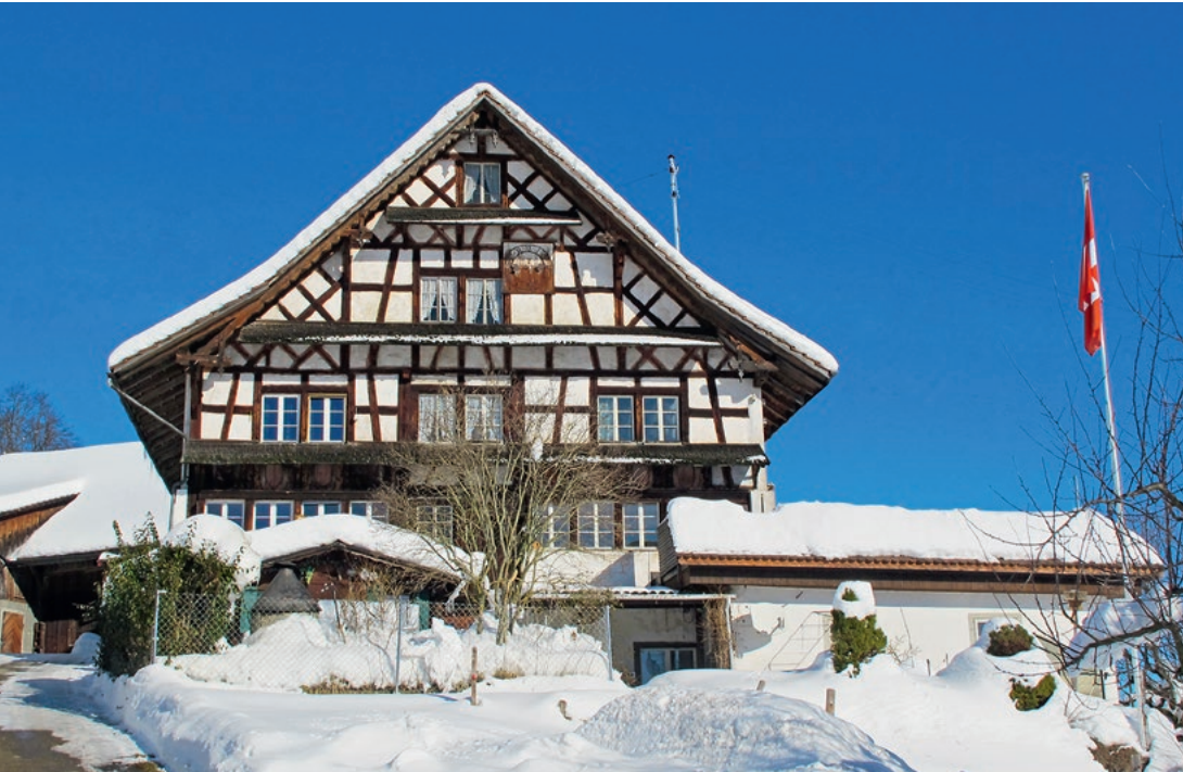
Der Fachwerkbau mit Klebdächlein und Uhr an der Fassade zeugt von seinen einst begüterten Erbauern. (Foto: Marcel Sandmeyer)
