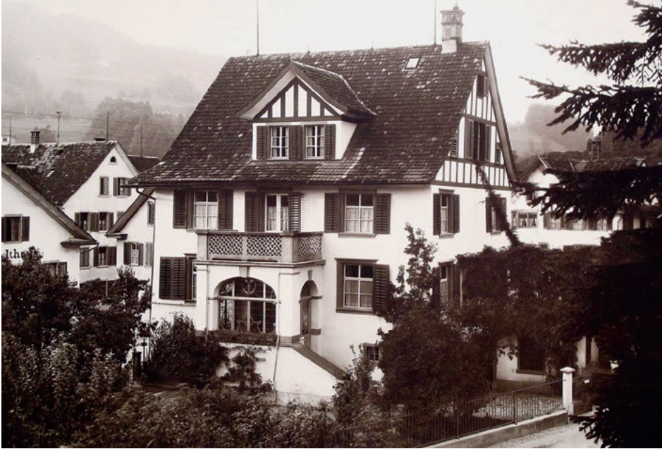
Die Helferei am Dorfplatz vor 1958. Der Garten und der Vorbau mit Balkon mussten dem Ladenanbau weichen. (Archivbild: Erika Müller/Marcel Sandmeyer)
