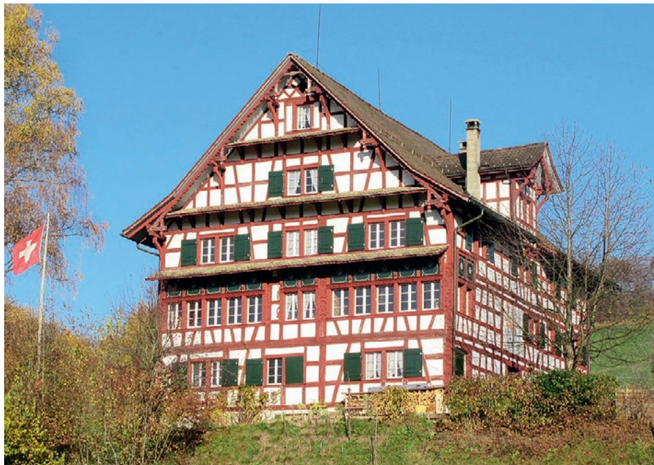
Mit ihrer Grösse und dem klaren, durchgestalteten Sichertriegelwerk bildete das Herrschaftshaus damals einen Markstein im Zürcher Oberländer Fachwerkbau. (Fotos: Marcel Sandmeyer)
