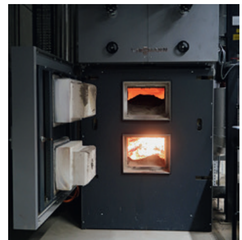
Nicht nur fürs Hallenbad, auch für den Wärmeverbund erbringt der Ofen eine Leistung von 550 Kilowatt.
