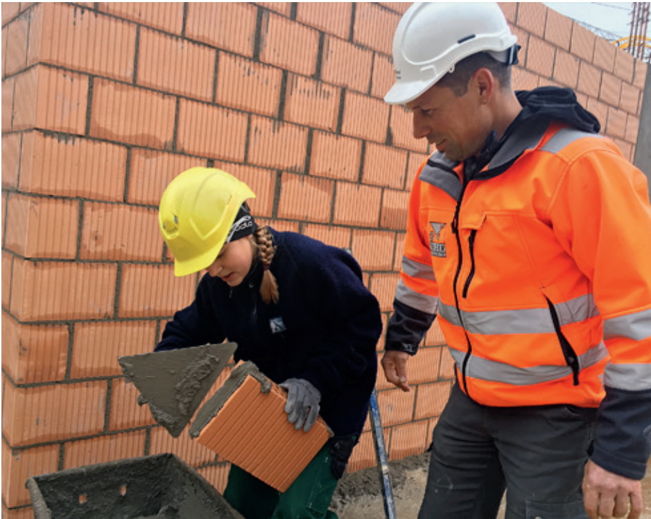
Lena mit Markus Stalder auf der Baustelle: Kraft, Koordination und Handgeschick sind gefragt. (Fotos: Irene Lang)
