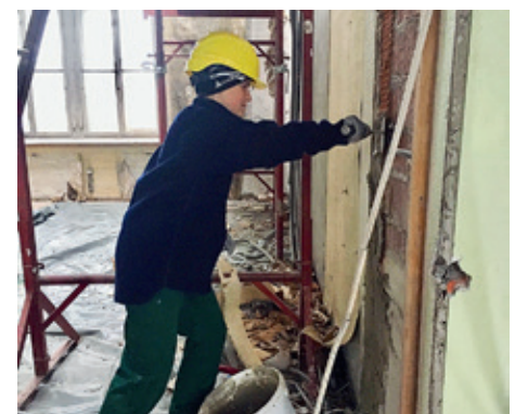
Brandschutz: Balken mit Feuerschutz behandeln.
