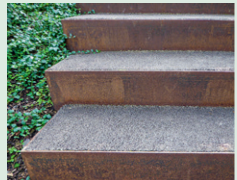
Die Heferentreppe wird erneuert und als Stahltreppe mit ausbetonierten Trittflächen und Zwischenpodesten ausgeführt. (Foto: zVg)
