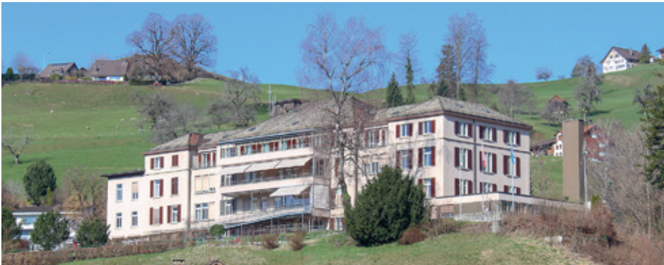
Das Pflegezentrum und das Altersheim Drei Tannen zügeln 2020 ins Rosenthal. An der erhöhten Lage über dem Dorf soll im ehemaligen Spital eine Siedlung für altersdurchmisches Wohnen entstehen. (Fotos: Werner Brunner)
