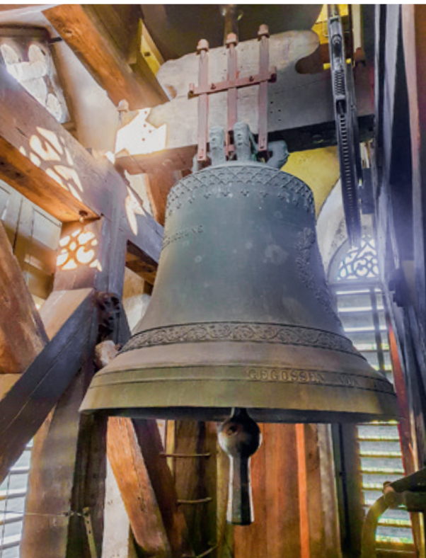
Bei den Glocken der reformierten Kirche sind einige Renovationsarbeiten geplant. (Foto: zVg)
