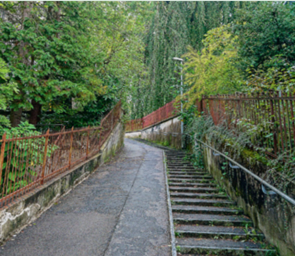
Die Stützmauer am Kanzleiweg, einer wichtigen Verbindung ins Walder Dorfzentrum, wird saniert. (Foto: zVg)
