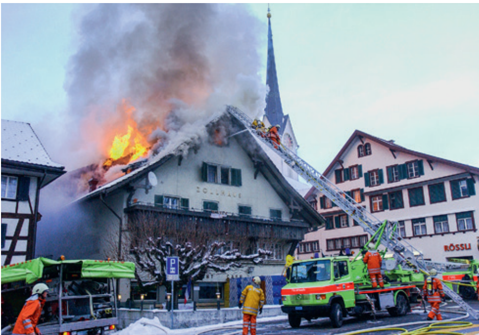
Das Zollhaus und das Haus Steinfels brannten bis auf die Grundmauern nieder. (Foto: zVg Feuerwehr Wald)
