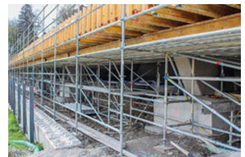
Rund 300 Kubikmeter alter Beton musste mühsam weggespitzt und entsorgt werden.
