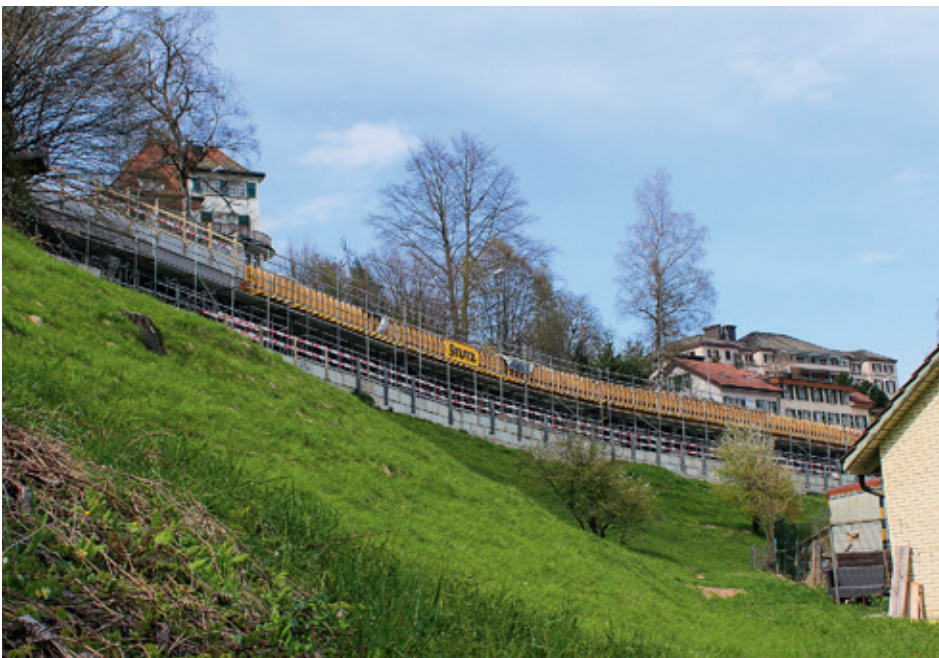
Der Lehnenviadukt als Strassenstütze talwärts. (Fotos: Werner Brunner)
