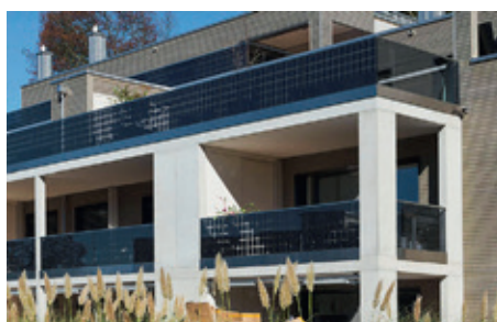
Vertikale Solarmodule an Balkonbrüstungen (Foto: zVg)
