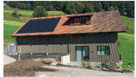
Nutzung im ganzen Tagesverlauf: Module sind nach Osten und Westen ausgerichtet. Hier eine Indach-Ausführung. (Foto: zVg)
