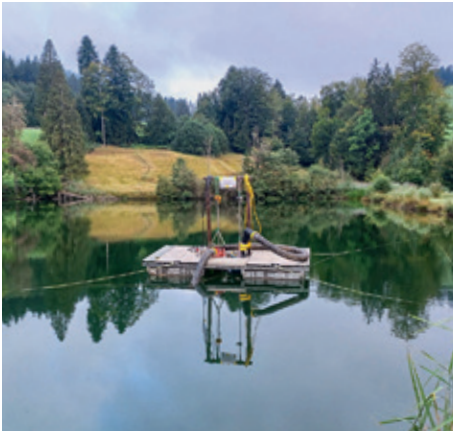
Die Pumpe liess den Wasserspiegel täglich um etwa 30 Zentimeter sinken. Hier beim Beginn des Ablassens...
