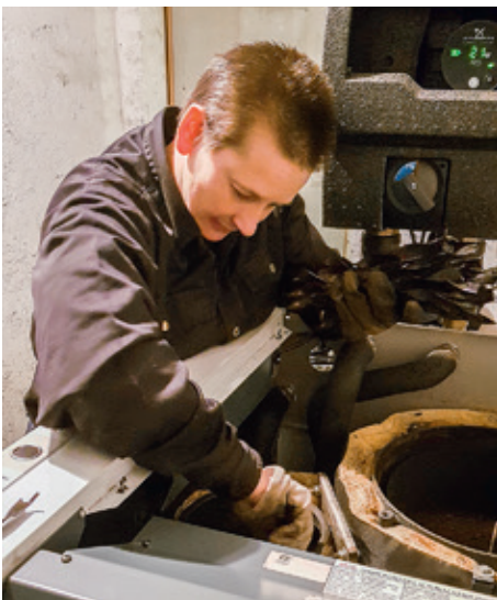
Sarina Sengl steckt die Metallspiralen zurück in die Öffnungen im Wärmetauscher. (Fotos: Salome Wildermuth)
