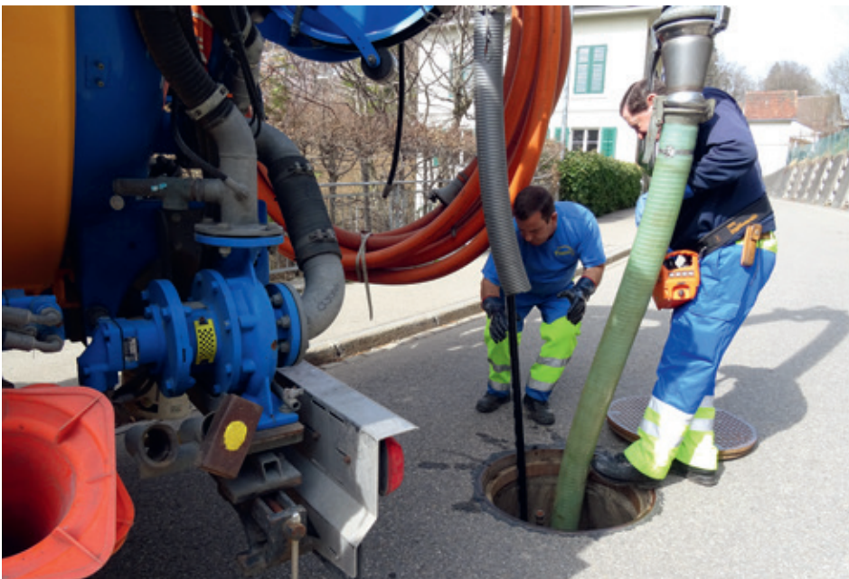
Manuel Silva (links) und Mato Ivankovic führen den Spül- und Saugschlauch in die Kanalisation ein. (Fotos: Sylvia van Moorsel)
