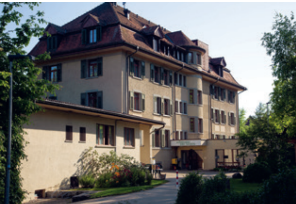
Das ehemalige Altersheim der Stiftung soll verkauft werden. (Fotos: Matthias Hendel)
