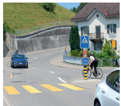
Schwachstelle Tösstalstrasse: Abrupter Seitenwechsel. (Foto: Martin Stucki)
