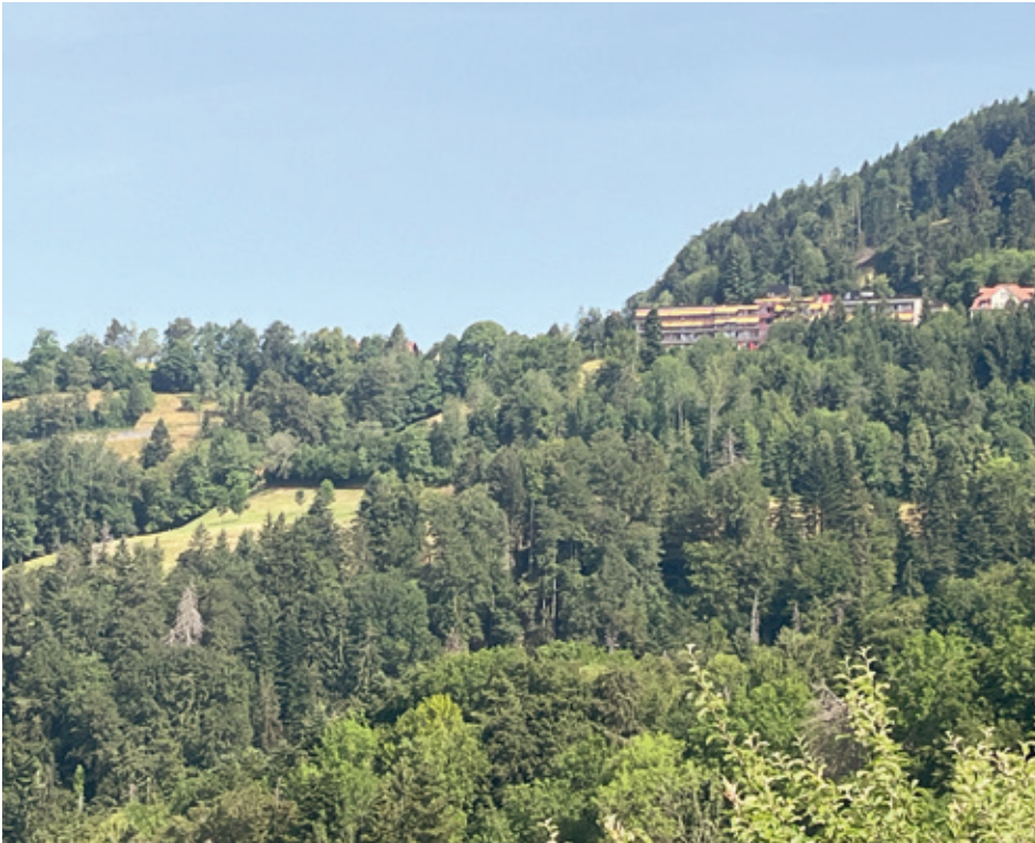
Die bevorzugte Lage wird aufgegeben und die bisherige Klinik zurückgebaut. Der Neubau des Rehazentrums soll auf der Wiese links davon gebaut werden. (Foto: Werner Brunner)
