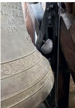
Die Viertelstunden- und Stunden-schläge erfolgen mittels Hammerschlag auf die Glocke.
