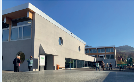
Trakt der Tagesstrukturen mit dem neuen Schulhaus-trakt dahinter. (Foto: Sebastian Brunner)
