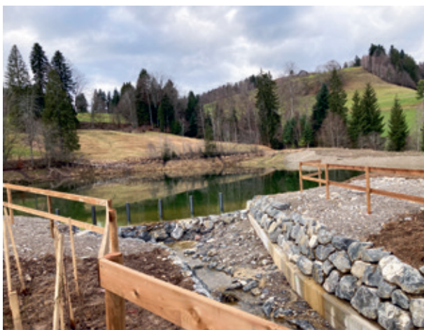
Neu: Rechen, Damm und Abfluss. Die Brücke und der Wanderweg über die Dammkrone fehlen noch. Ein Umweg ist signalisiert.
